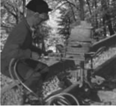
படம் 3.11 இரயில் தண்டவாளங்களை தெர்மிட் முறையில் (Thermit process) இணைத்தல்
